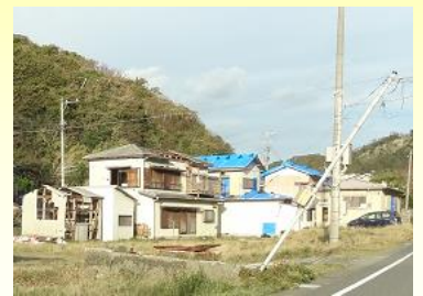
被害の大きかった岩井袋地区。屋根が吹き飛ばすほどの強風だったそうです。細い柱も曲がってしまっています。
